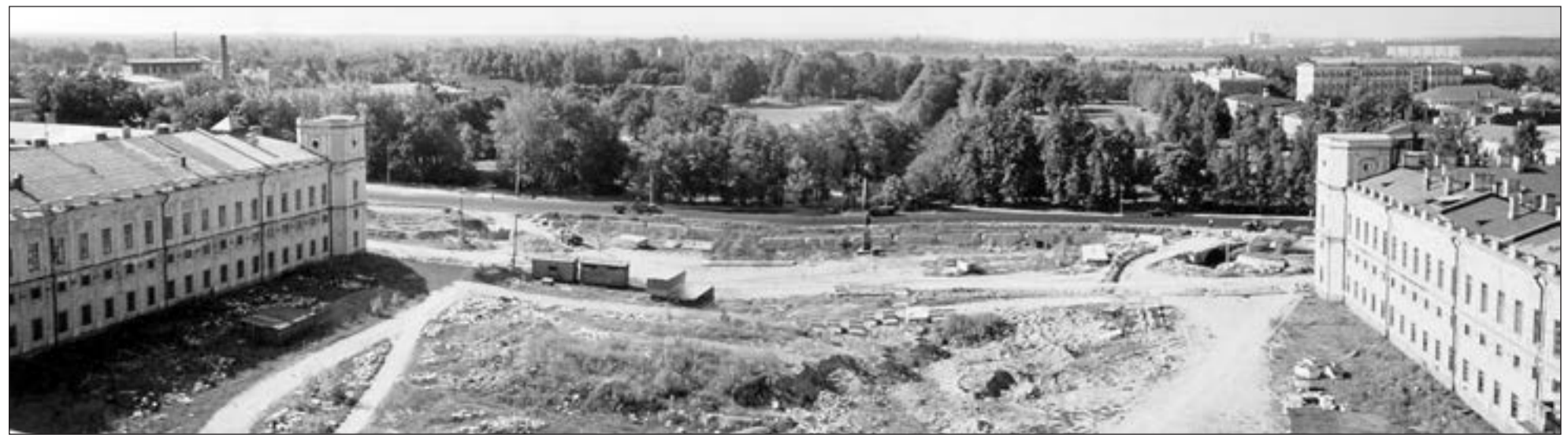
Работы по реконструкции дворцового плаца. 1978 г. Фото Владислава Циунелиса
